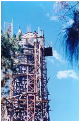
Construcción de Estatua del Cristo de El Picacho, encofrado de Moldes. Fototeca del Dr. Jorge Amaya. 1997.
