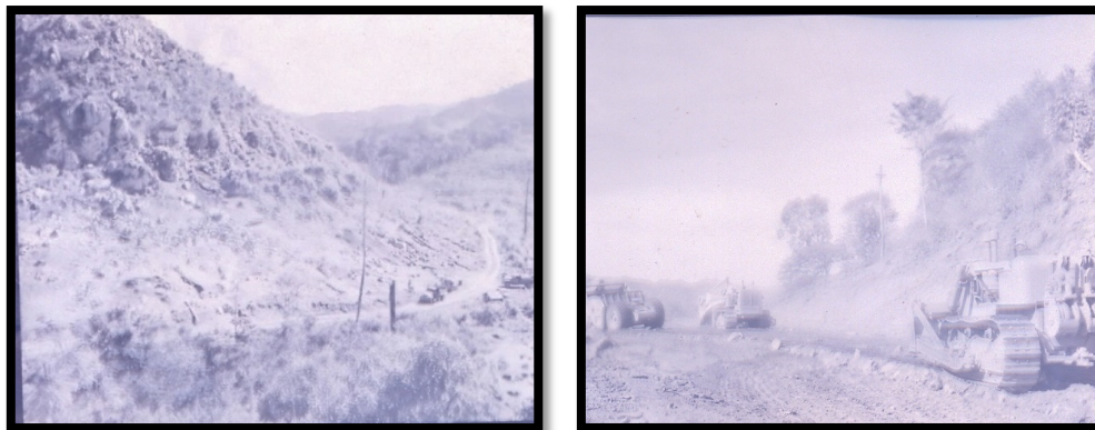
Imagen No. 5. Construcción de ejes carreteros.
